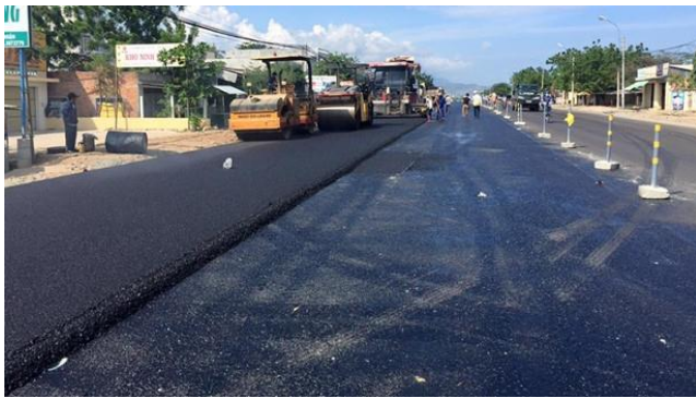
Hình 2. Thảm mặt đường bê tông nhựa nóng [3]
